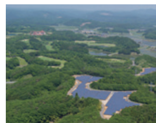
リゾートトラスト メガソーラー那須白河
