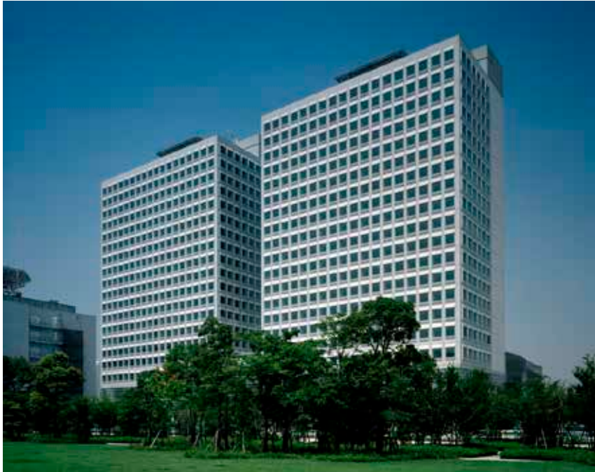
TOC Ariake exterior
